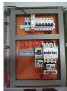
As versões ECQUC1 são controladas pelo pressostato de baixa e por isso, não possuem controlador digital. As versões PW, possuem sistema de partida dividida, com sistema duplo de acionamento que utiliza um timer para acionamento seqüencial de acordo com as especificações do fabricante do compressor.
